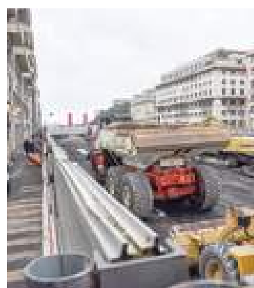
Il cantiere della Foce
