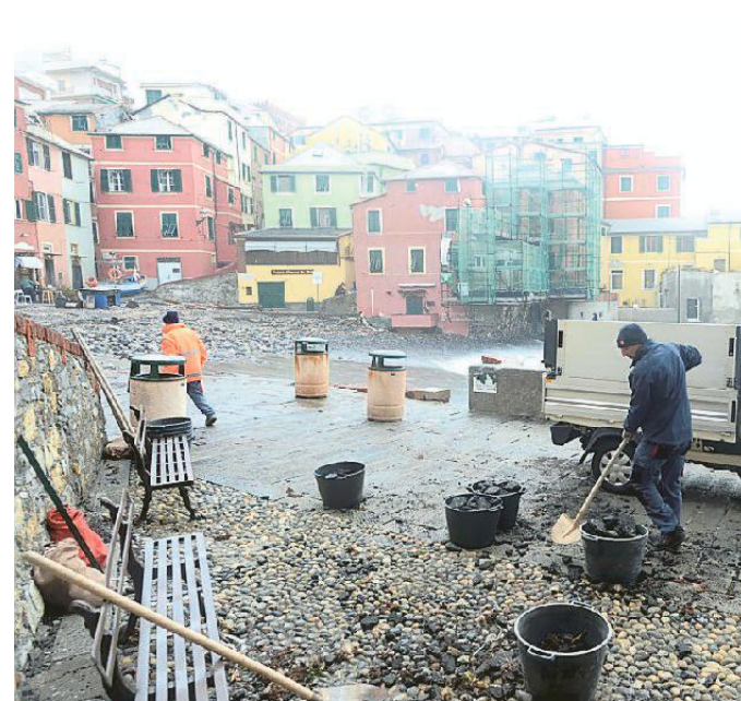
Lavori a Bocca d'Assa dopo i danni provocati da una mareggiata
